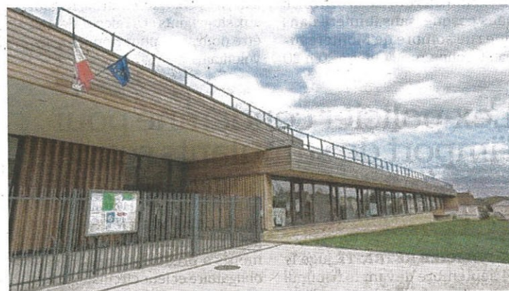
Mercredi. L'école a été intégrée au cycle de visites d'architecture du Caue77.
