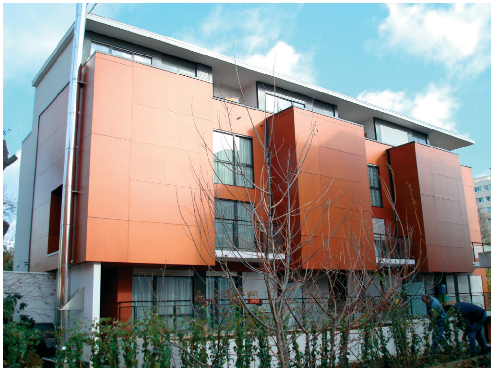
Vue du bâtiment A © Christelle Lecoœur
