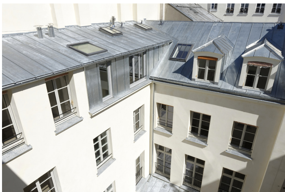
La nouvelle toiture du bâtiment de jonction et du bâtiment en fond de cour
