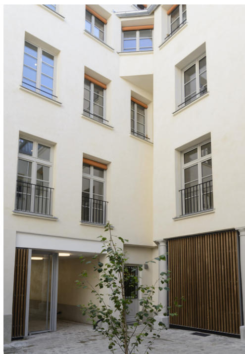
La cour intérieure et le porche d'entrée © Mohamed Khalfi
