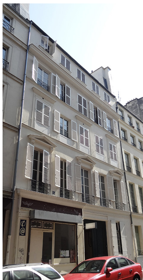
Photos avant intervention
