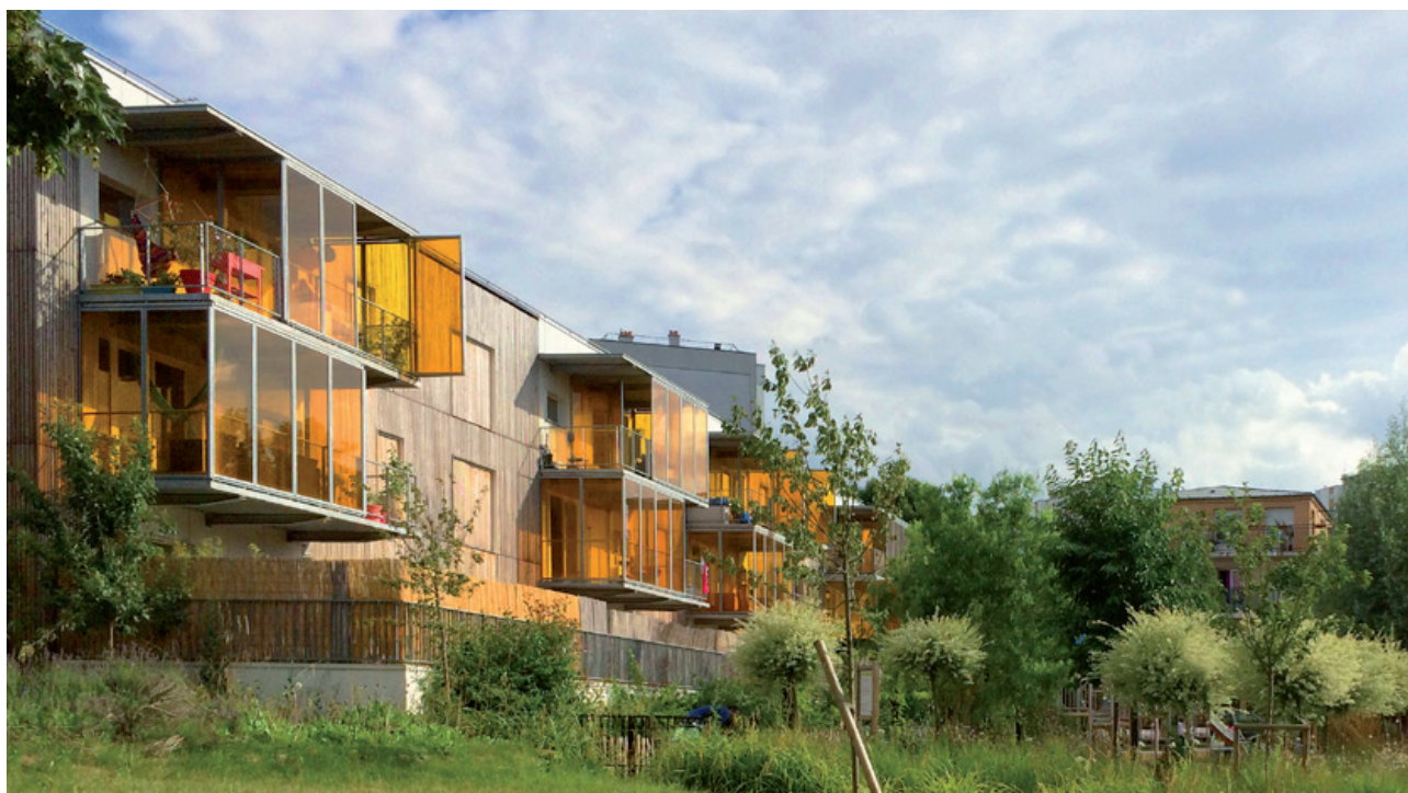
Vue sur l'opération depuis le petit bras de Seine
