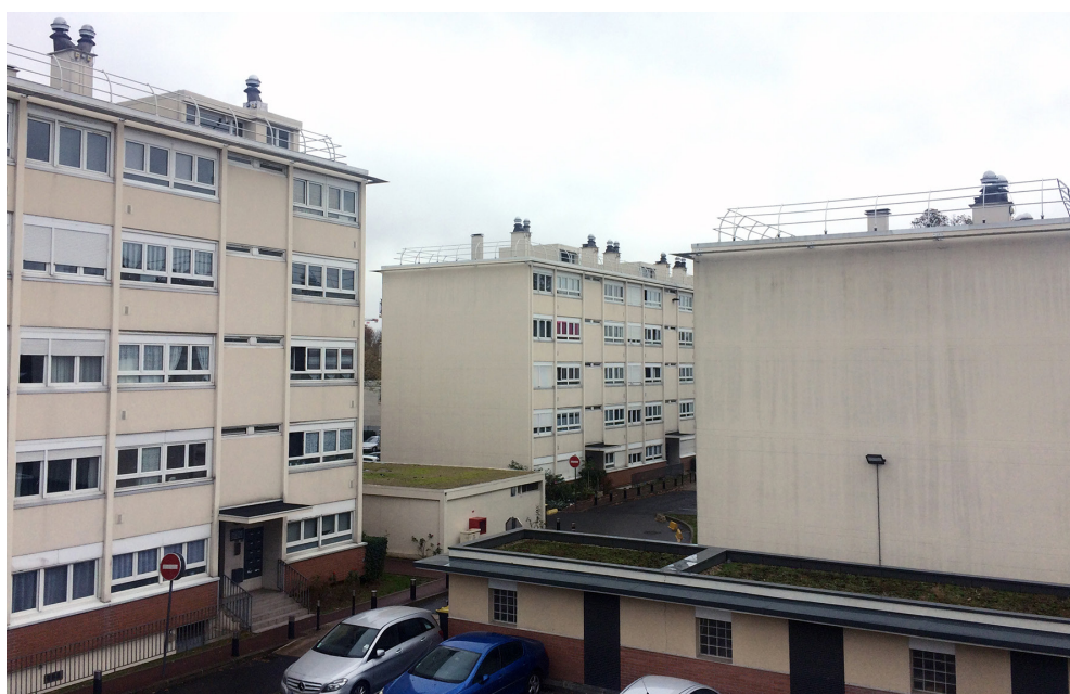
Etat avant travaux : alternance de travées avec menuiseries à 3 vantaux, 4 vantaux et travées avec prises d'air des séchoirs © Djuric Tardio Architectes
