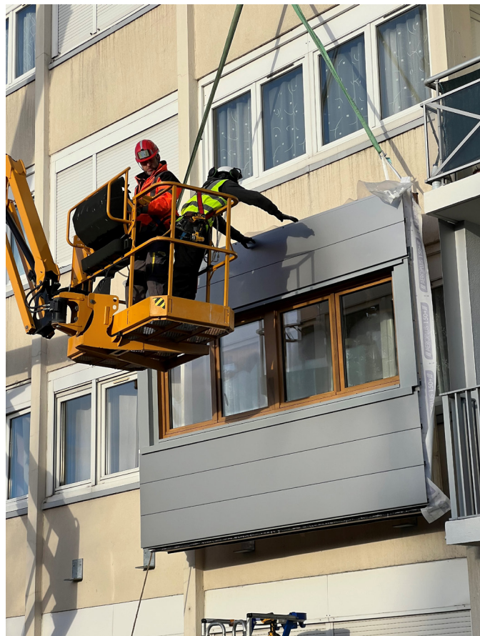
Pose d'un panneau préfabriqué © Djuric-Tardio Architectes
