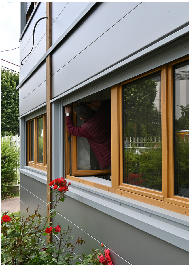
Finitions après la pose des panneaux et des couvre-joints © CAUE94, 2024
