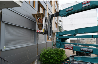
Pose et finition des modules préfabriqués ©CAUE94, 2024
