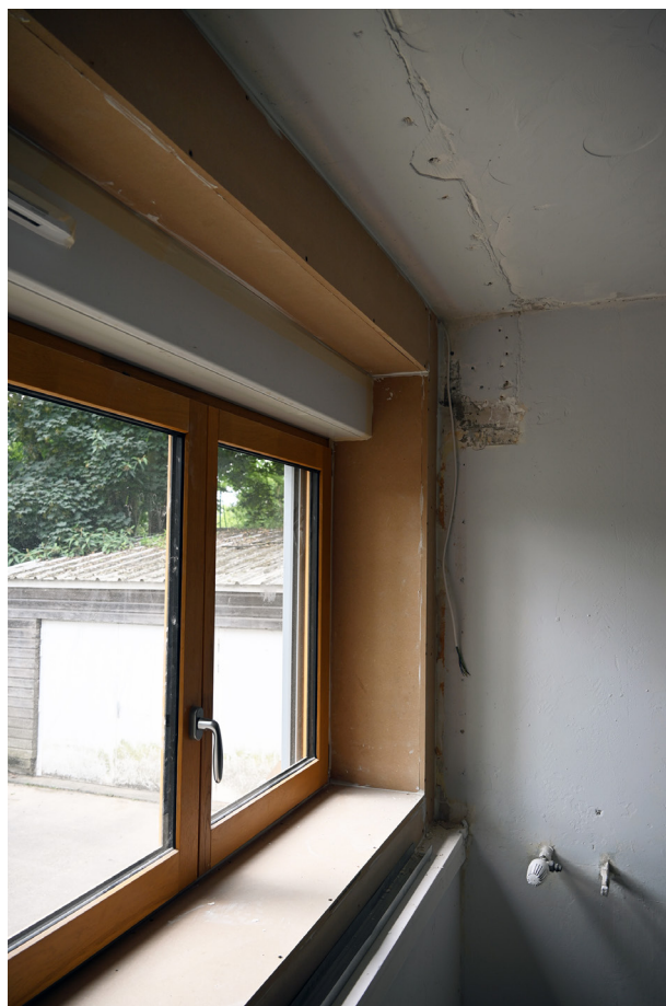
Pose de l'habillage du tableau de raccord masquant le dormant conservés © CAUE94, 2024
