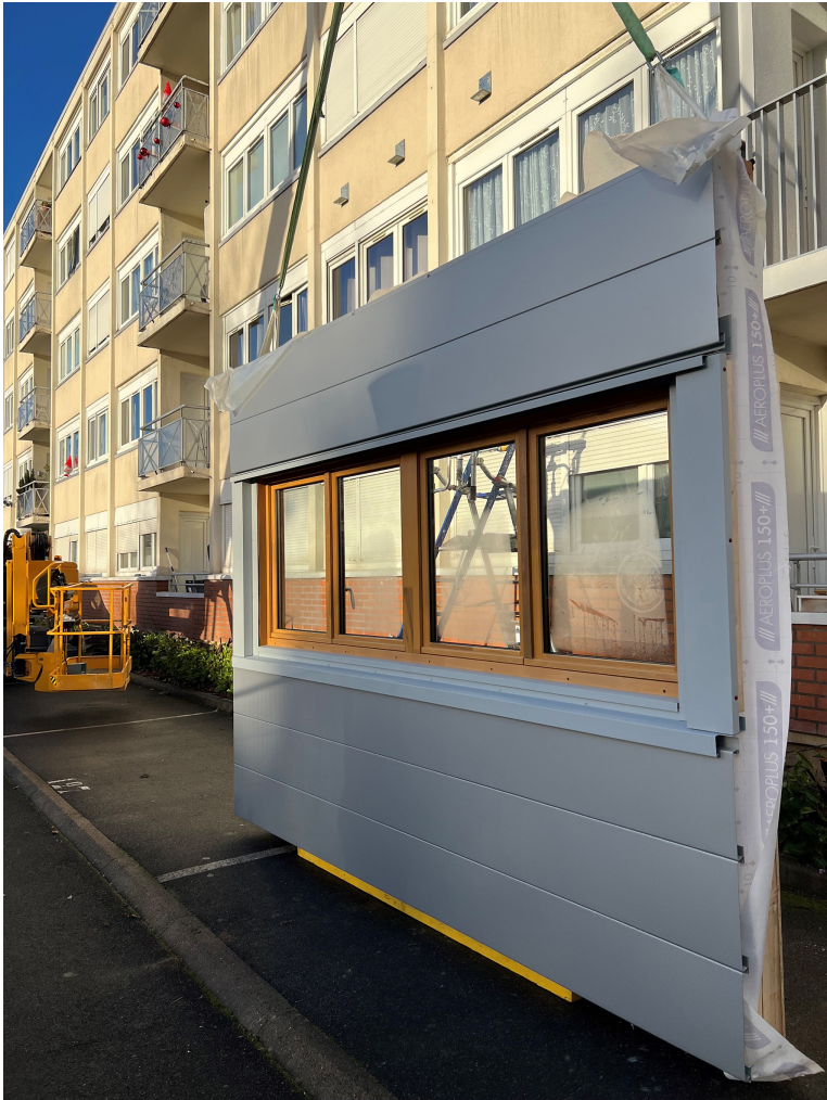
Prototype de panneau en structure bois présenté sur le site © Dimitri Djuric
