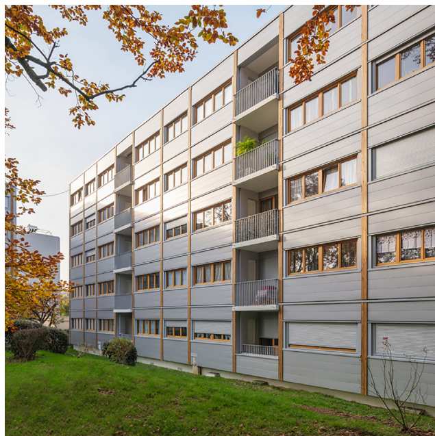
Vue de la même façade à l'achèvement des travaux fin 2024 © Dimitri Djuric
