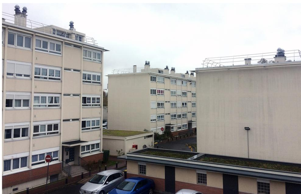
Etat avant travaux : alternance de travées avec menuiseries à 3 vantaux, 4 vantaux et travées avec prises d'air des séchoirs
