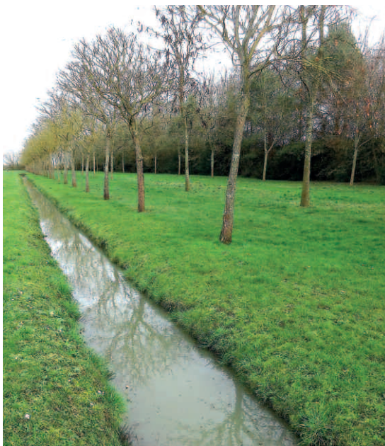
Fossés remplis d'eau le long de l'allée des Princes à Combs-la-Ville. Des fossés larges et profonds bien reliés entre eux et au réseau hydrographique permettent de stocker l'eau tout en favorisant un bon état des plantations. Ils assurent le drainage de sols trop souvent engorgés en période hivernale dans de nombreux secteurs de la Seine-et-Marne.
