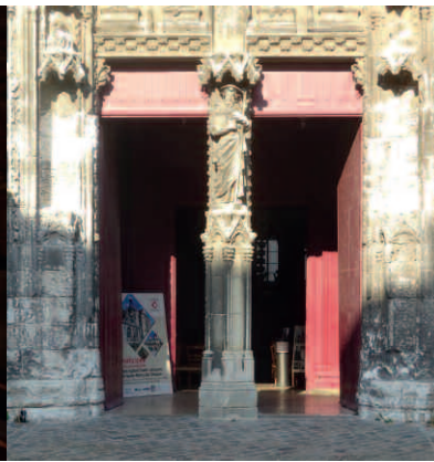
L'art de bâtir en lien avec le sol en place : premier rang de pierres et roche taillés pour s'assembler (soubassement d'une chapelle romane).
