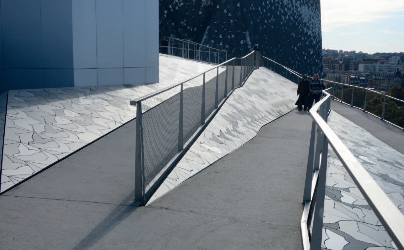
Accès au toit de la Philharmonie de Paris. Architecte Jean Nouvel.
