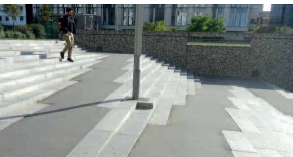
« Rattrapages » : une rampe en travers de l'escalier, une solution élégante, qui ne génère aucune charge d'entretien ultérieure.
