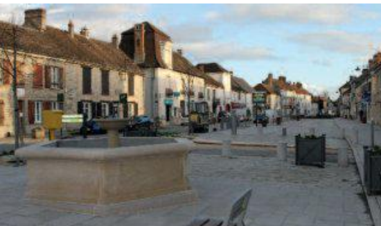
Rue principale de La Chapelle-la-reine rénovée.
