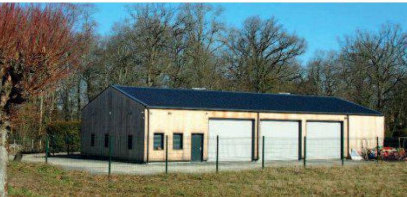
Le nouvel atelier municipal bardé de clins de mélèze pour une meilleure intégration dans le paysage. La toiture recevra prochainement des capteurs photovoltaïques.
