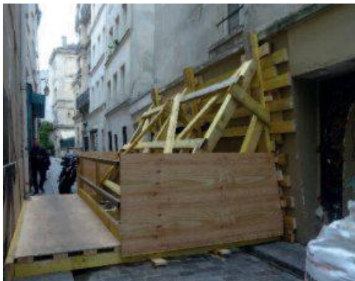
Ouvrage de soutènement d'un immeuble menaçant de s'effondrer, Paris, 2018. On évite la catastrophe mais où et quand la prochaine alerte ? Comment mieux diagnostiquer pour éviter d'en arriver là ?
