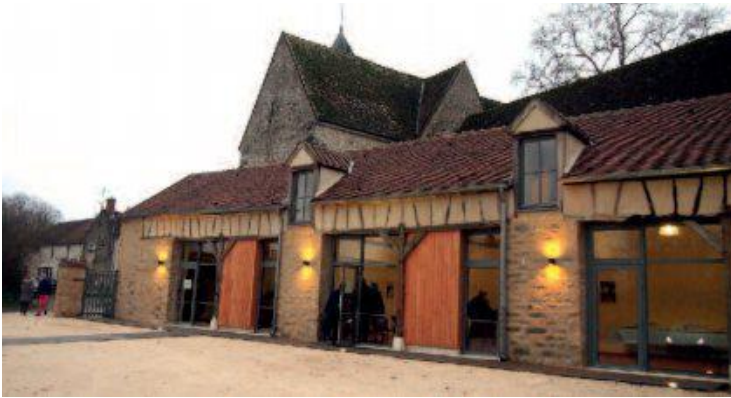
Salle de la Source. Réhabilitation d'un bâtiment ancien en salle polyvalente destinée à la bibliothèque, à la musique et autres activités culturelles.
