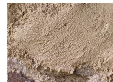
Serré et "gratté fin" ou lissé, l'enduit recouvre entièrement les pierres d'une couche de quelques centimètres
