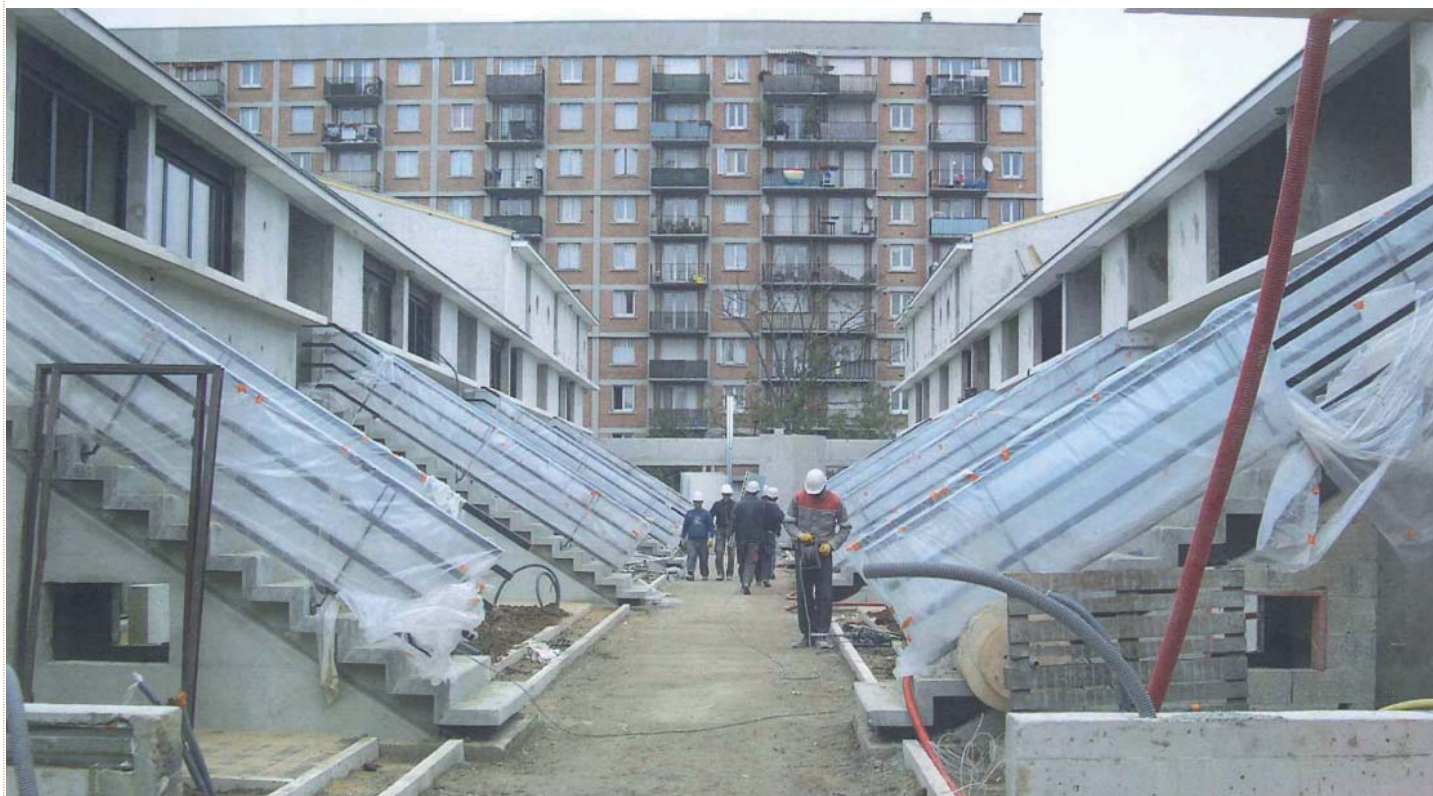
Vue d'une «courée» en chantier avec en fond de parcelle le bâtiment «A» de la Vache Noire avant sa démolition.
