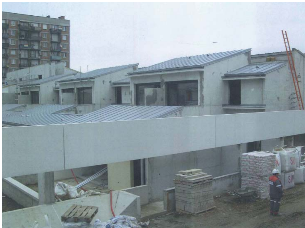
Vue du bâtiment C en cours de construction. Jeu de volumes, décrochements de façades et terrasses suspendues.
