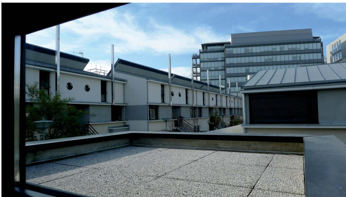
Vue des toitures en zinc et des « mâts » en inox qui rythment la façade du bâtiment A.
