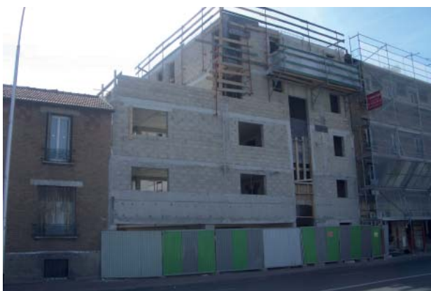
La façade nord maçonnée en parpaings pleins de la partie neuve et l'immeuble réhabilité en ravalement.
