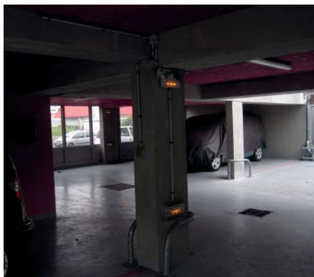
Vue du parking ouvert vers la rue.
