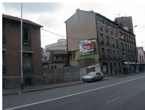
Le site avant construction.
