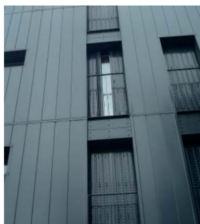
Sur cour une façade métallique sombre dont les fenêtres sont occultables par des persiennes.
