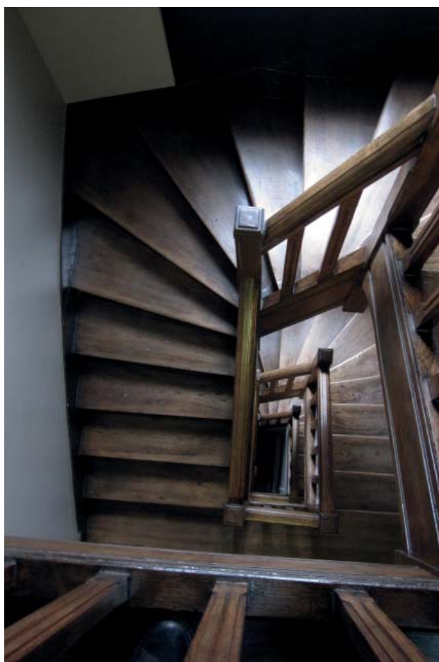
L'escalier conservé dans le bâtiment réhabilité.
