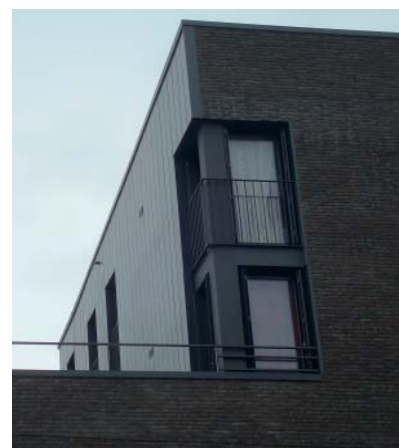
La présence du duplex marque l'angle de la façade principale qui se retourne et est soulignée par un changement de matériau.
